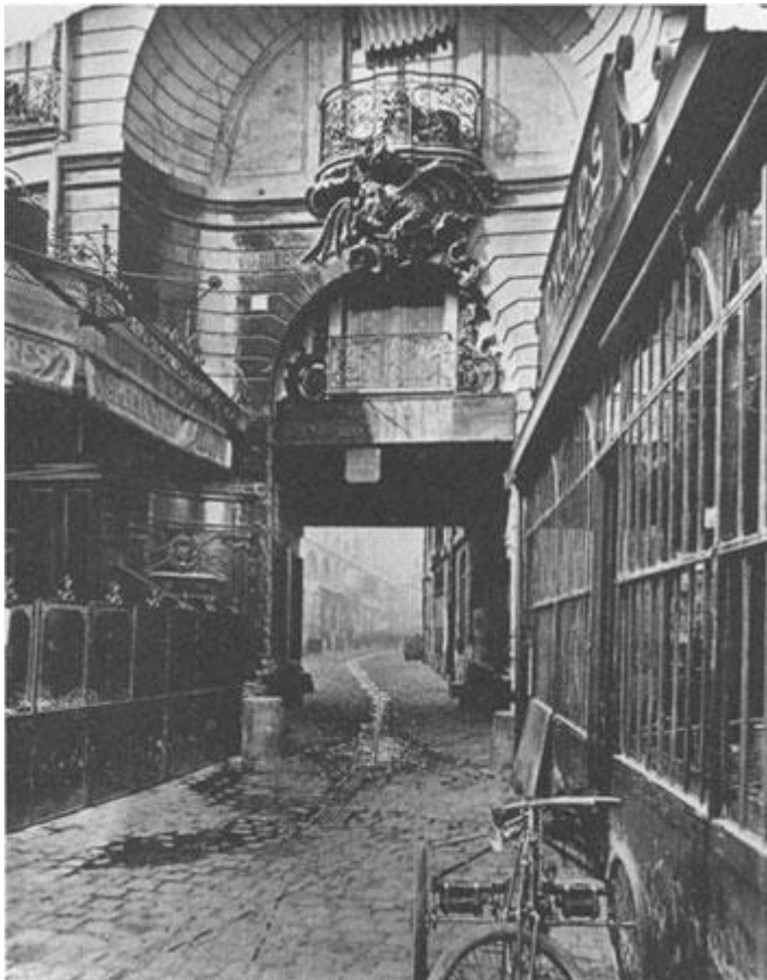
Atget, Entrée de la cour du Dragon, 50, rue de Rennes
